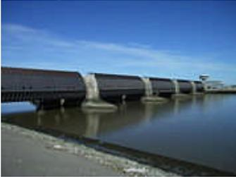
Das Eidersperrwerk befindet sich an der Mündung der Eider bei Tönning. Hauptzweck des Sperrwerks ist der Schutz vor Sturmfluten der Nordsee, es ist das größte deutsche Küstenschutzbauwerk. Ebenfalls sollte es zum wirtschaftlichen Aufschwung in den Kreisen Norderdithmarschen (heute Teil des Kreises Dithmarschen) und Eiderstedt (heute Teil des Kreises Nordfriesland) beitragen.
